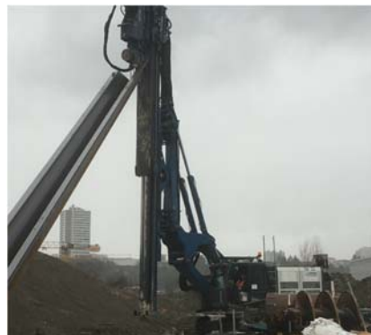
Abbildung 3: ABI Teleskopmäkler TM 22
