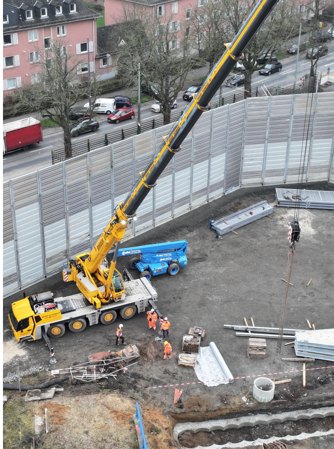
Errichtung der Lärmschutzwand
